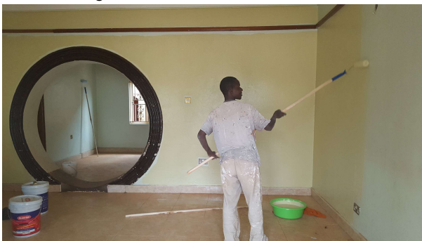
Renovierungsarbeiten im Wohnzimmer
