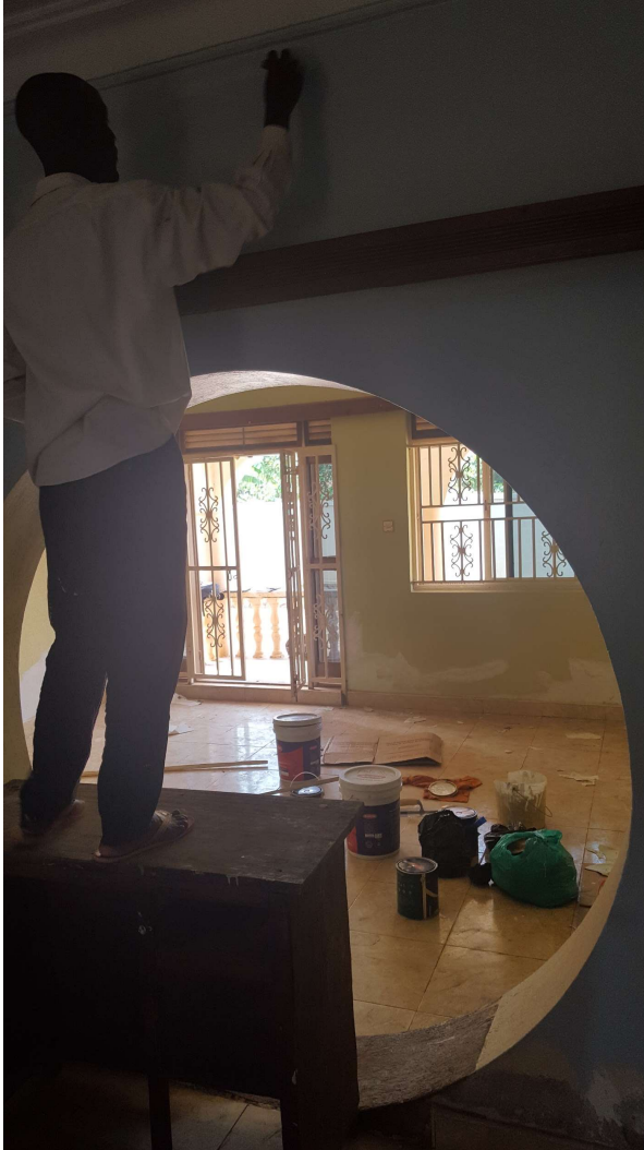
Renovierungsarbeiten im neuen Haus
